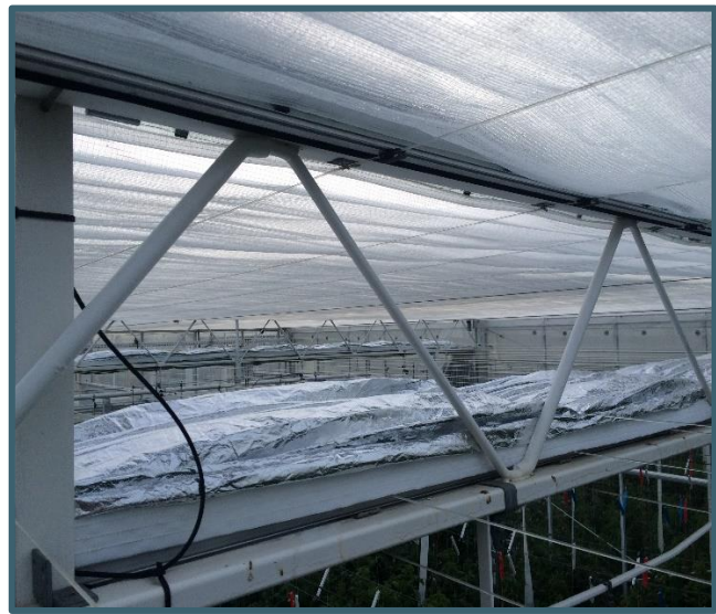
Figuur 2: Onderaanzicht (links) en zij aanzicht (rechts) van het EB nachtschermstelsel in een afdeling met tomaat op PSKW.
