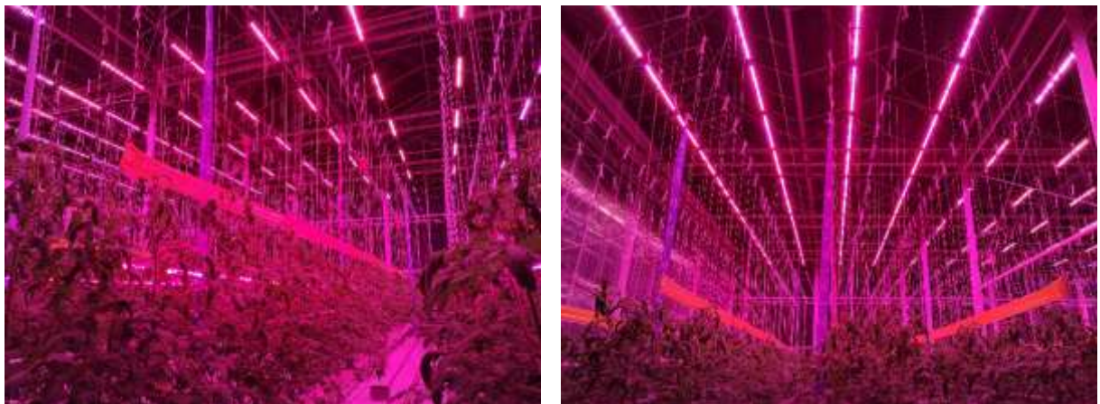
Foto 1 In de full-LED afdeling werd op twee verschillende manieren 210 \mu\text{mol}/\text{m}^2\text{s} geïnstalleerd. Enerzijds door de combinatie van 135 \mu\text{mol}/\text{m}^2\text{s} LED toplight en 75 \mu\text{mol}/\text{m}^2\text{s} LED interlight (links) en anderzijds door enkel toplight modules (rechts).
